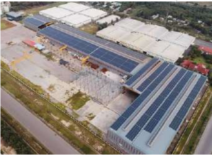
Rooftop solar power plant at Meizic Steel Building Co.,Ltd Dự án Điện mặt trời áp mái tại Nhà máy kết cấu thép Minh Trị
