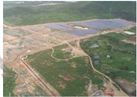
KN Van Ninh solar power plant Dự án Nhà máy Điện mặt trời KN Vạn Ninh
